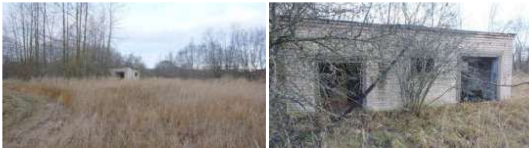
Nedzīvojamā ēka – degvielas noliktava ar kadastra apzīmējumu 7894 002 0093 017
